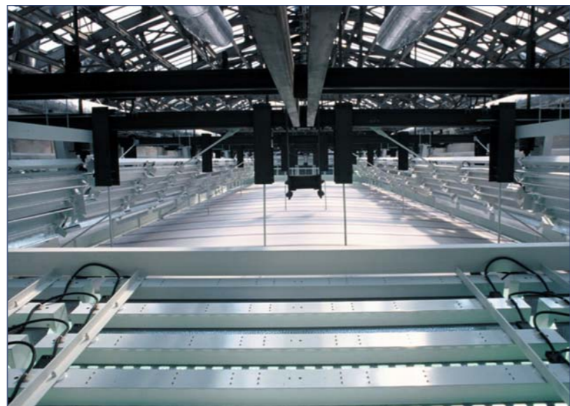
Vue longitudinale de la charpente : en haut, la toiture constituée de verrières maintenues par une ossature métallique. Sous la charpente, le filtre de Danpalon 16 mm, légèrement cintré, surplombant la verrière de la salle (non apparente sur la photo).
