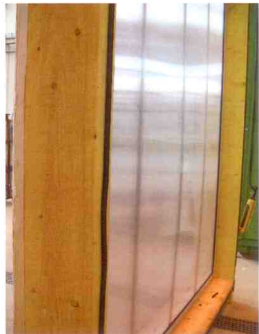
Vue côté extérieur
